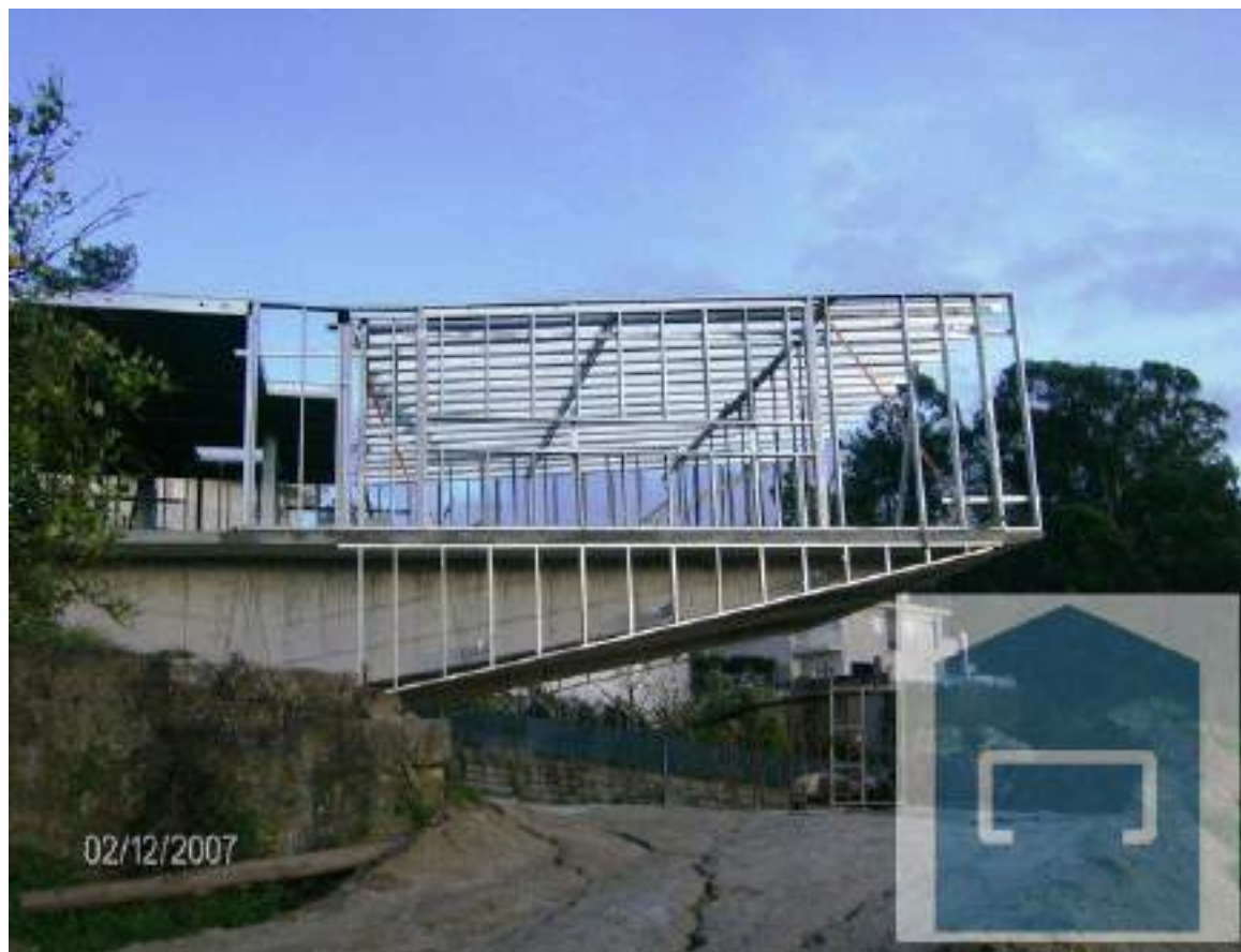
Morada com estrutura mista em Betão Armado– Penafiel
