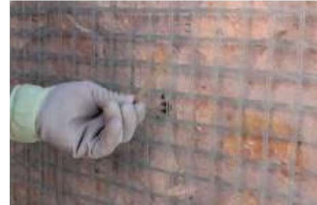
Colocação do conector
