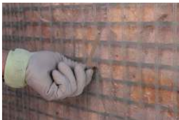
Colocação do conector
