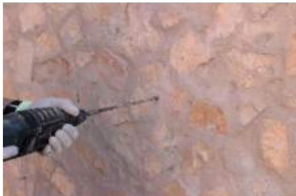
Execução dos furos no suporte
