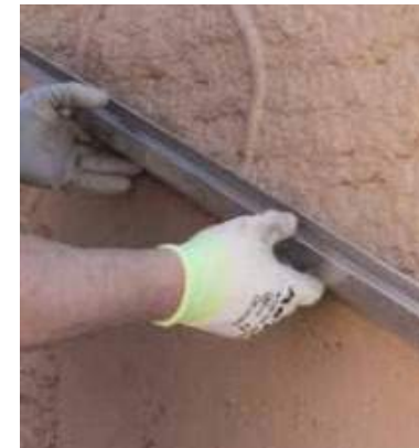
Passagem com régua e talocha
