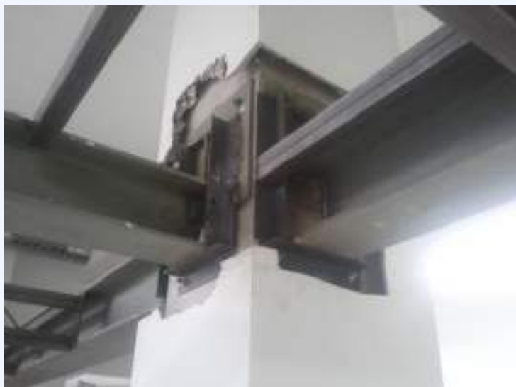
Ancoragens de elementos metálicos em paredes alvenaria ou betão
