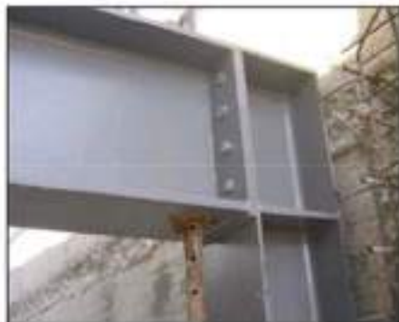
Ancoragens de elementos metálicos em paredes alvenaria ou betão
