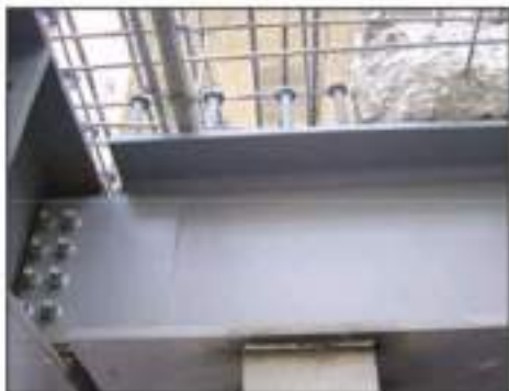
Ancoragens de elementos metálicos em paredes alvenaria ou betão
