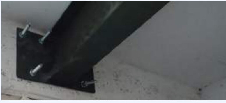
Ancoragens de elementos metálicos em paredes alvenaria ou betão
