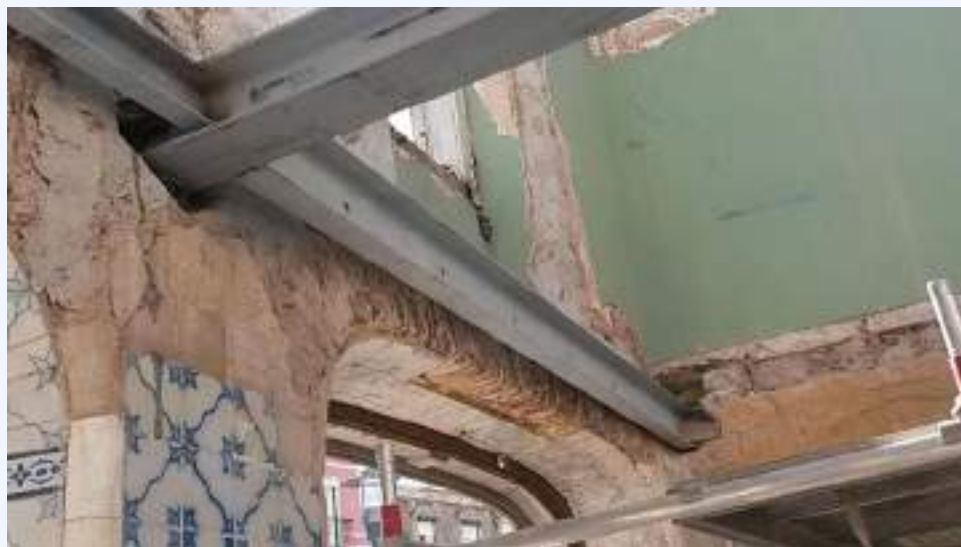
Ancoragens de elementos metálicos em paredes alvenaria ou betão
