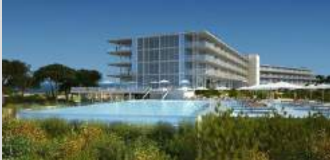
Hotel The Oitavos, Cascais – SAVE 1,4M€ (2600 ton. CO2 - 700 ton. CO2 de estrutura metálica)
