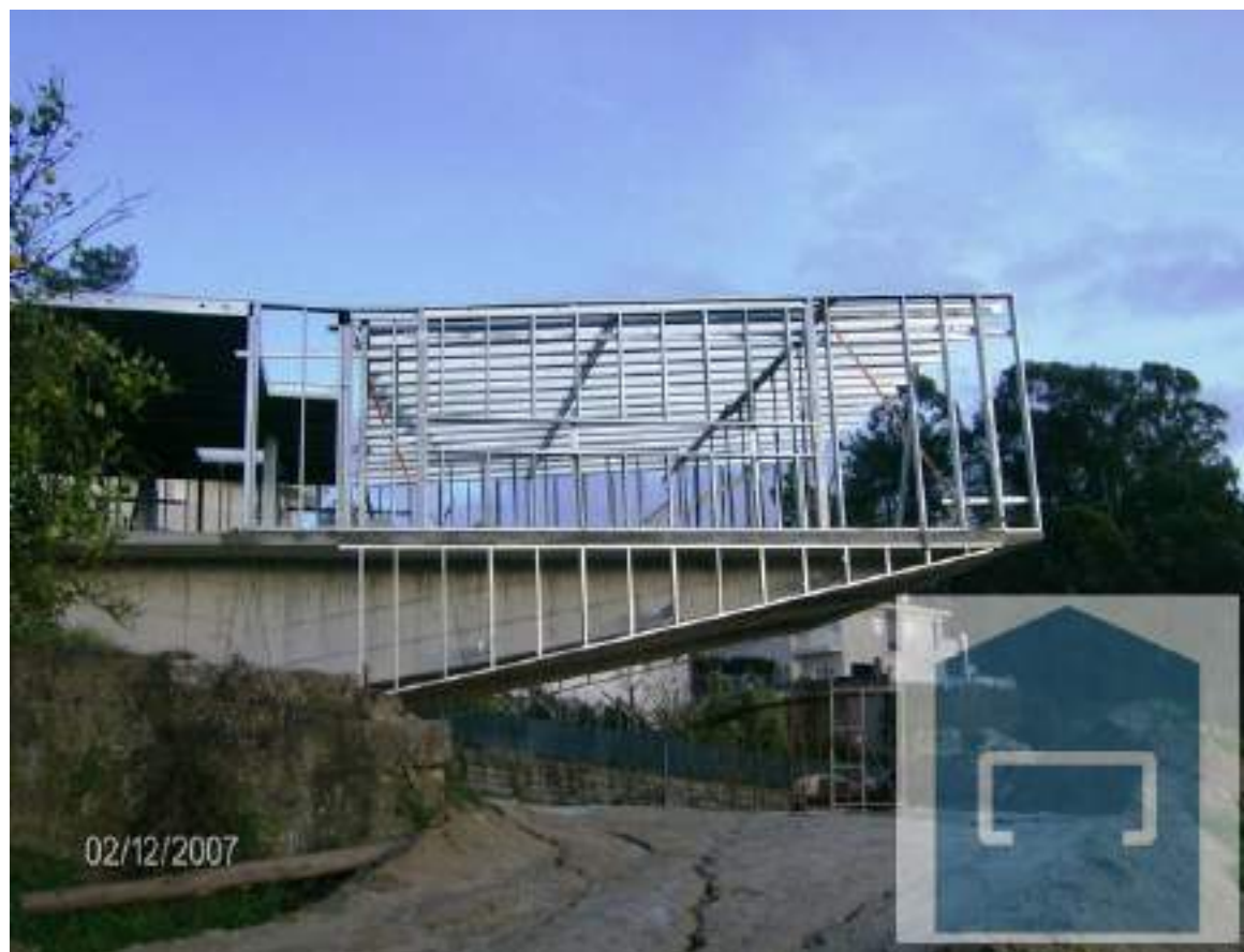
Moradia com estrutura mista em Betão Armado- Penafiel
