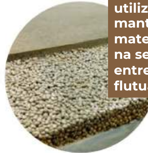
3 Após 24 horas o piso está apto para a colocação da betonilha final.
