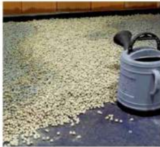
2 Rega superficial com aguada de cimento.
