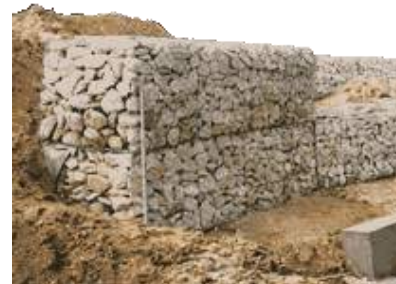
Uso de pedras locais na construção do edifício
