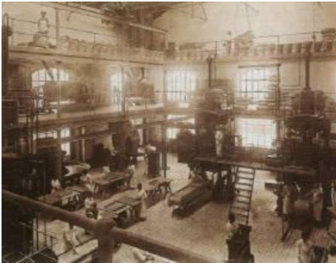
(Interior do edifício de fabrico de massas (Ed1), gaveto – foto de arquivo)
