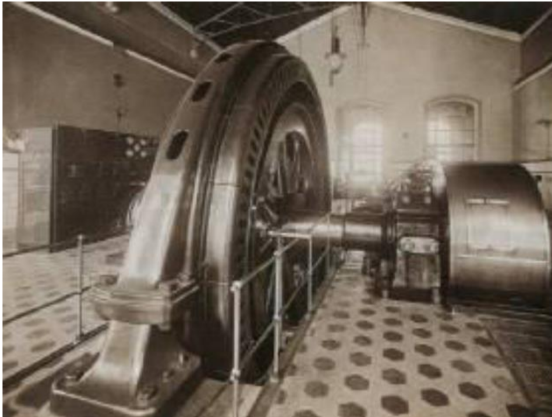
(Motor na central termoelétrica (Ed3) – foto de arquivo)
