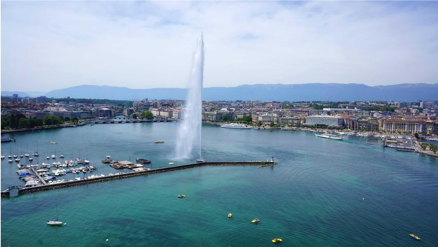
Genebra - utilização da água do lago para resfriamento dos edifícios
